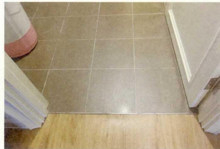
4 材质交接处采用隐形收边条，避免卫生间内外出现高差
