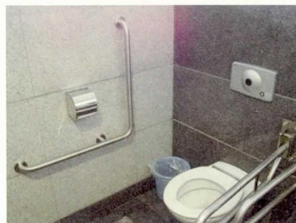
15 L形扶手安装方向反，老人无法借竖杆起身
