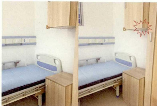
8 突出的吊柜角很容易磕碰老人头部
