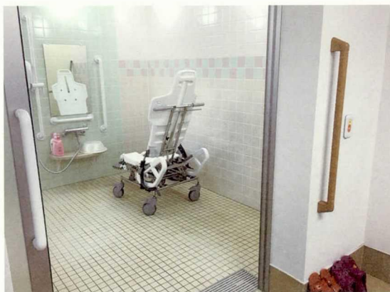
13 浴室门开启净宽大于1m，满足浴床、轮椅进出
