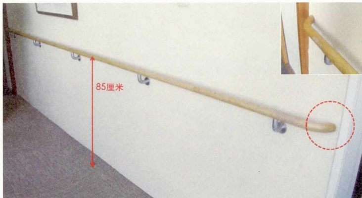
16 走廊中扶手的正确安装方式与端部处理方式
