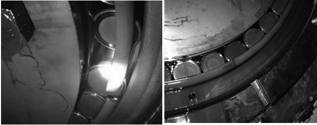
图4轴承实际故障图
